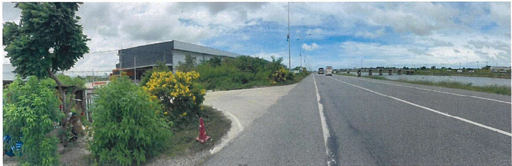
สภาพทั่วไปถนนคันคลองระบายน้ำสุวรรณภูมิ (ฝั่งซ้าย) บริเวณแยกเข้าโครงการบางกอกฟ्रीเทรดโซน 6
