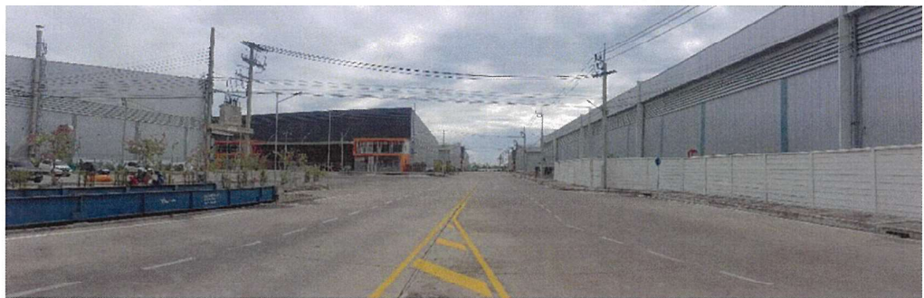
สภาพทั่วไปถนนสายหลักภายในโครงการฯ
