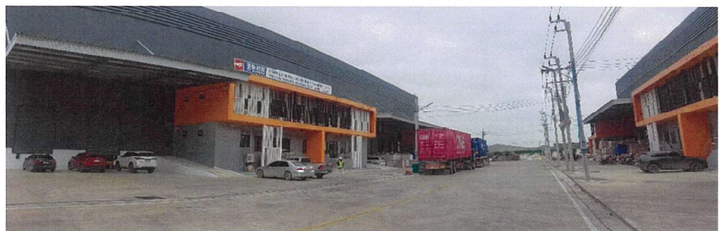
สภาพทั่วไปถนนสายรองภายในแปลงที่ดินทรัพย์สิน
