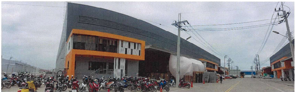
สภาพทั่วไปสิ่งปลูกสร้างอาคารทรัพย์สินฯ
