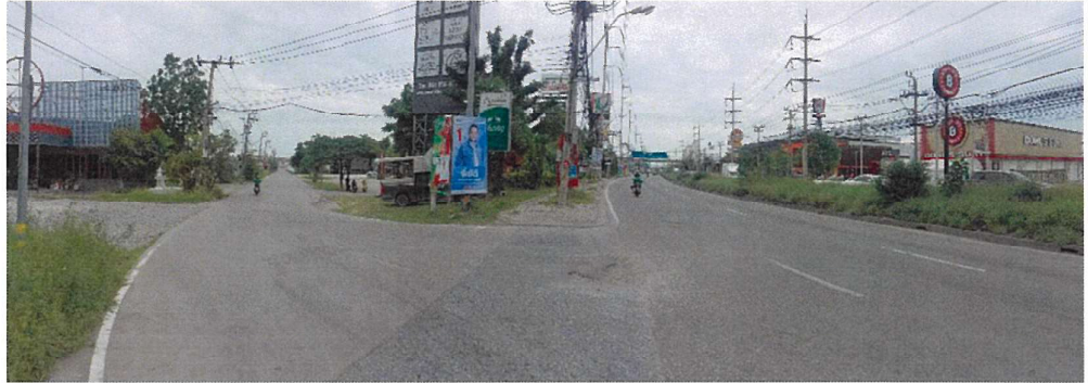
สภาพทั่วไปถนนเทพารักษ์ (ทล.3268) บริเวณแยกเข้าซอยจรงเจริญ
